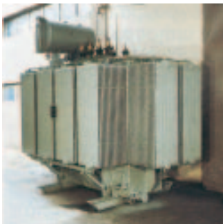
(α) ΑΜ/Σ 10.000kVA, 15/20kV
